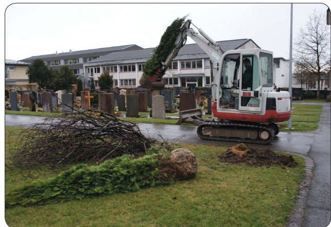
Die japanischen Zierkirschbäume wurden entfernt, die alten Wurzelstöcke gerodet
